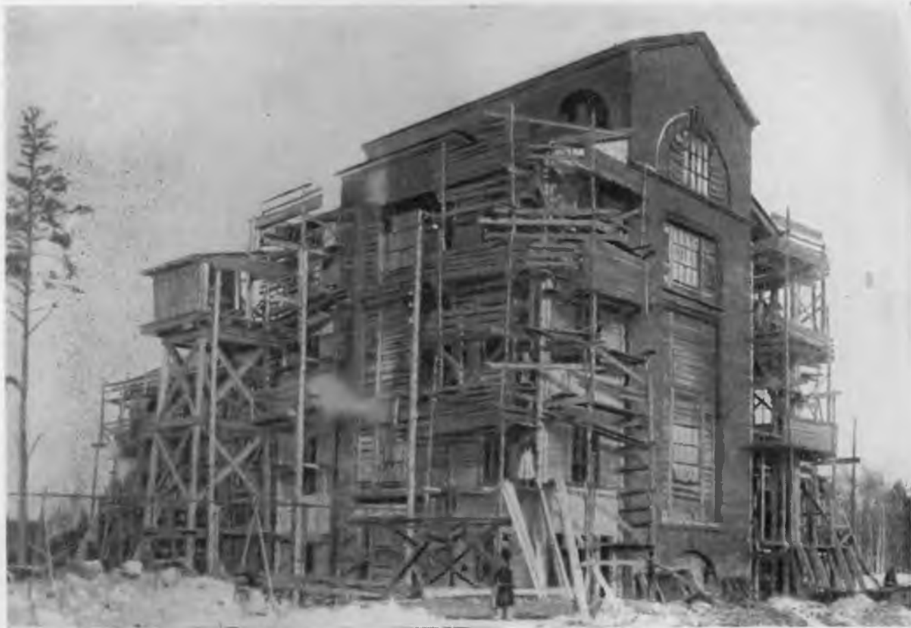
Строительство подстанции Шатурской ГЭС. 1920 г. (Фото.)
