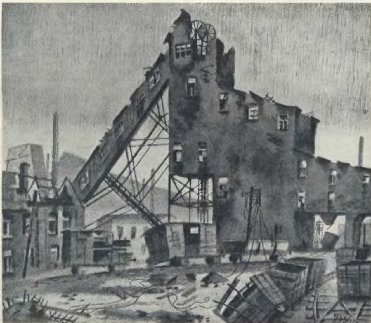
Разрушенная и покывутая шахта. Рис. Н. Дормидонтова.
