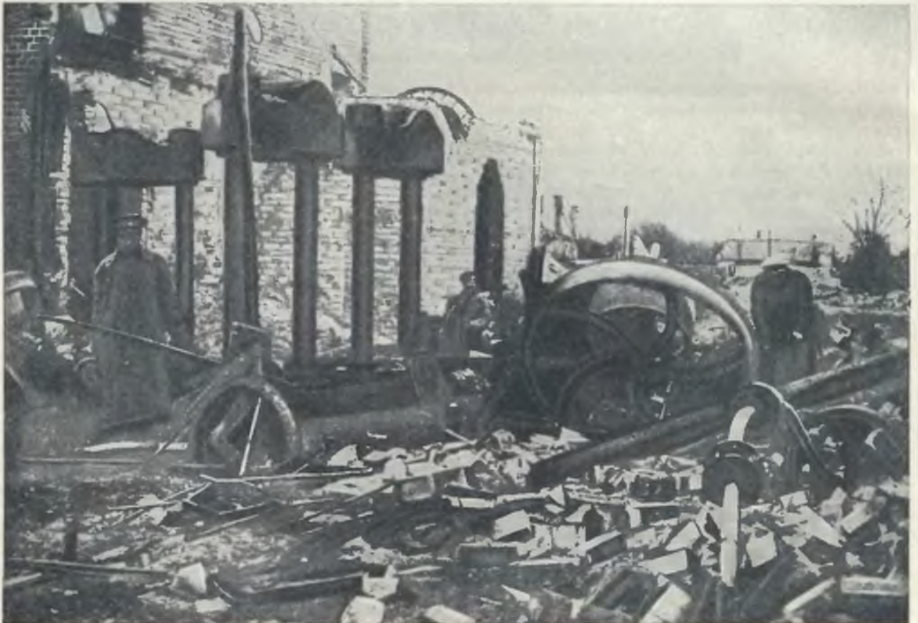
В прифронтовой полосе. Разрушенные фабрики.
